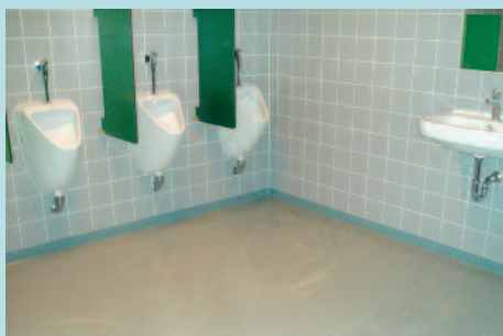
Nieuwe toiletvloer: hygiënisch, lange levensduur en hoge slijtvastheid
